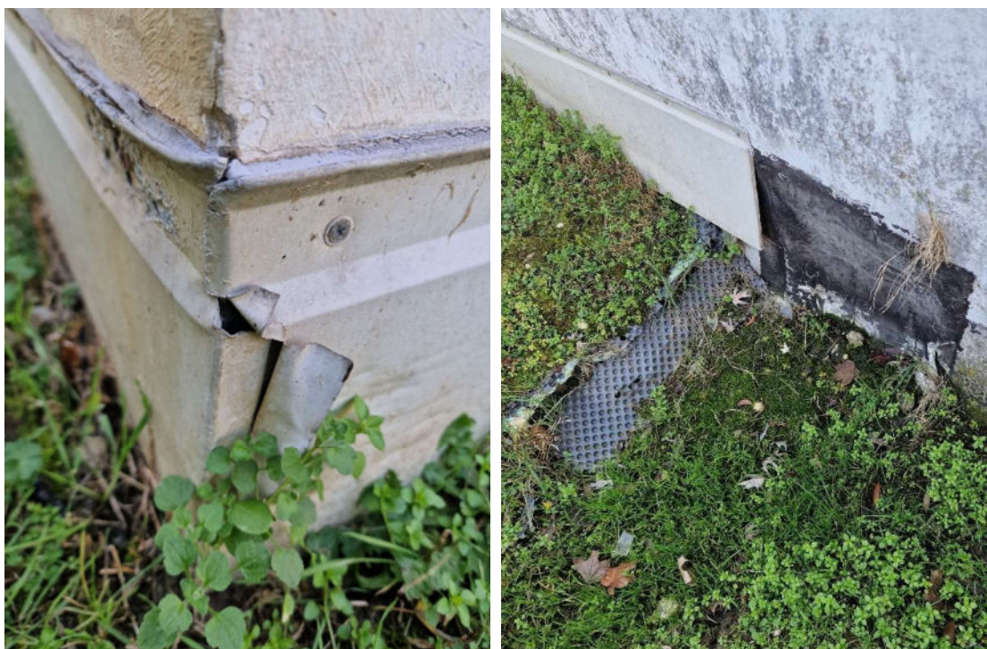
Donji dio nadozida rampe sa strane zelene površine
