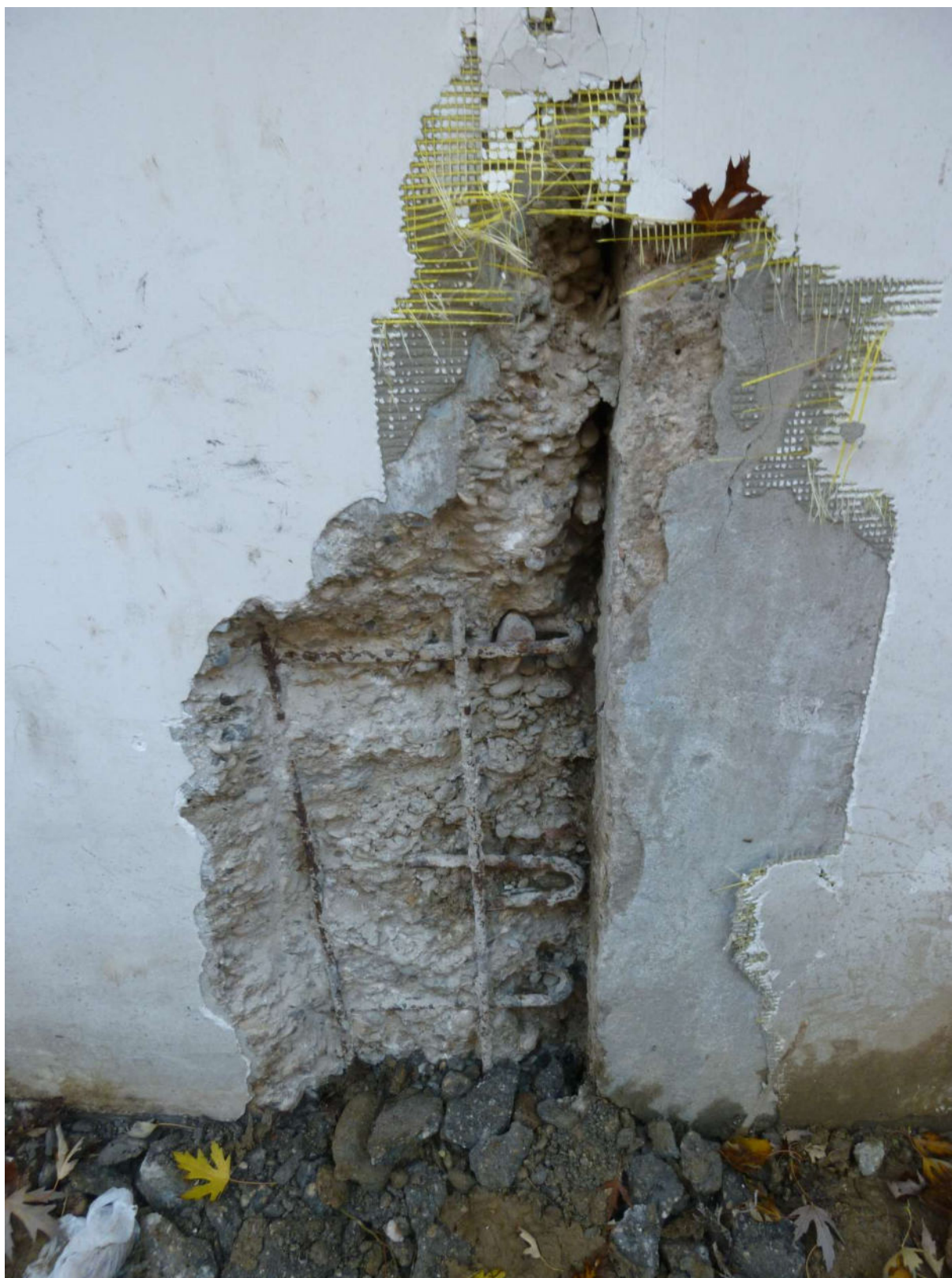
Istražni radovi iz 2013.g. – AB potporni zid – d=35cm
