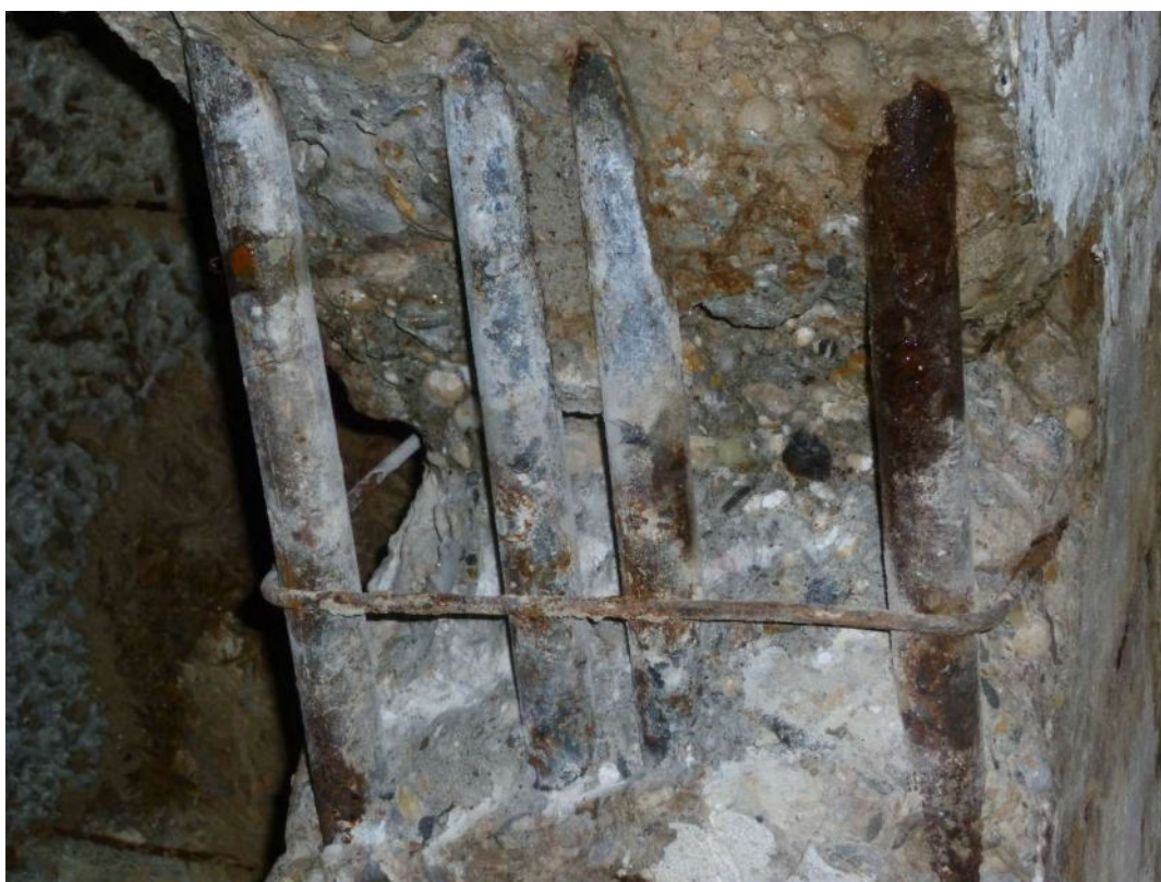
Istražni radovi iz 2013.g. – AB grede garaže – 30/60cm –
